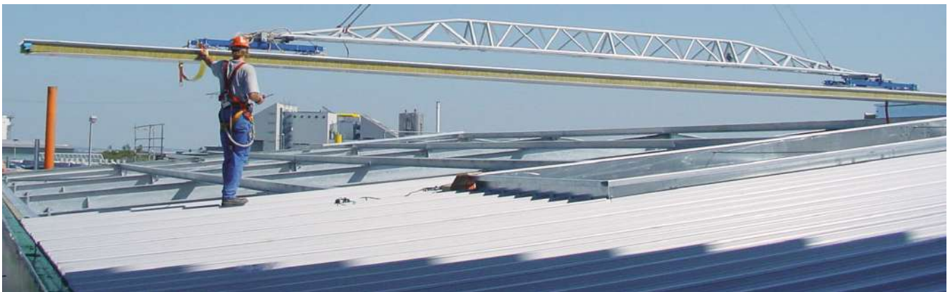
Beispiel einer Dachmontage mit Traverse
