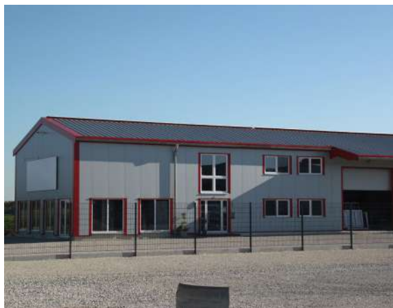
Produktionshalle mit Büro
