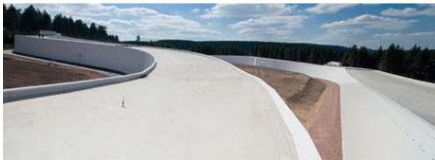
Differenzierte Gebäudeformen mit ROMA Schnellbau-Dämmpaneel (Skihalle Oberhof)
